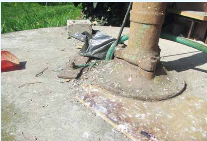
Studna znečištěná ptačím trusem
